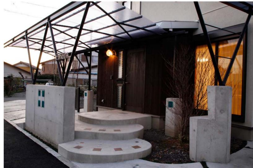
玄関扉にはピーラ材（米松の良材）を使用し、落ち着いたダークブラウンに塗った。ポーチは半透明の屋根と斜めの鉄骨で軽快に。結果、和風モダンのおしゃれな雰囲気に仕上がっている。
