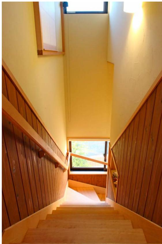
階段の踏み板と手すりは、長く使うほど味わいが出る。腰壁は杉板に自然塗料塗り。上部は珪藻土入り塗り壁。上部の高窓は、夏の暖気を抜くのに効果がある。下の窓は、庭の緑が目に入るように考慮
