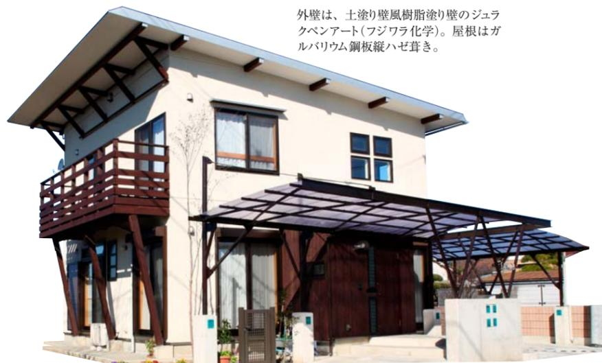
外壁は、土塗り壁風樹脂塗りのジュラクペンアート（フジワラ化学）。屋根はガルバリウム鋼板縦ハゼ葺き。
