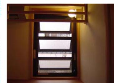
●オーニング窓 上下に繋がった窓が同時に斜めに開く窓。窓が庇のように前面にせり出すので、多少の雨なら開けっぱなしにしておいても大丈夫。外出時や夜間にも開けておける。
