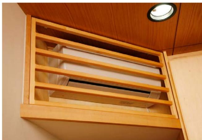
部屋の雰囲気が壊れないように、エアコンはむき出しにしないで木の枠で覆っている。涼しい空気を取り込み、暖まった空気を上に逃がす風の流れができていますので、夏もエアコンに便りすぎることなく暮らしている。
